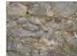
Elementi lapidei parzialmente enucleati in profondità (inferiore alla metà del concio)
