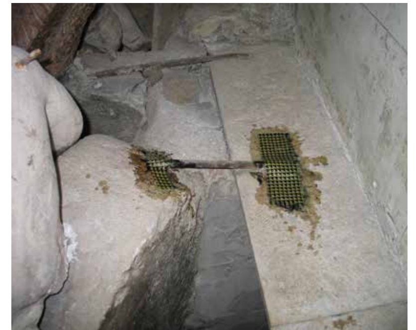
392 Altare laterale della Sacra Famiglia: consolidamento di una staffa di ancoraggio alla muratura. Foto di A. Marchesi
