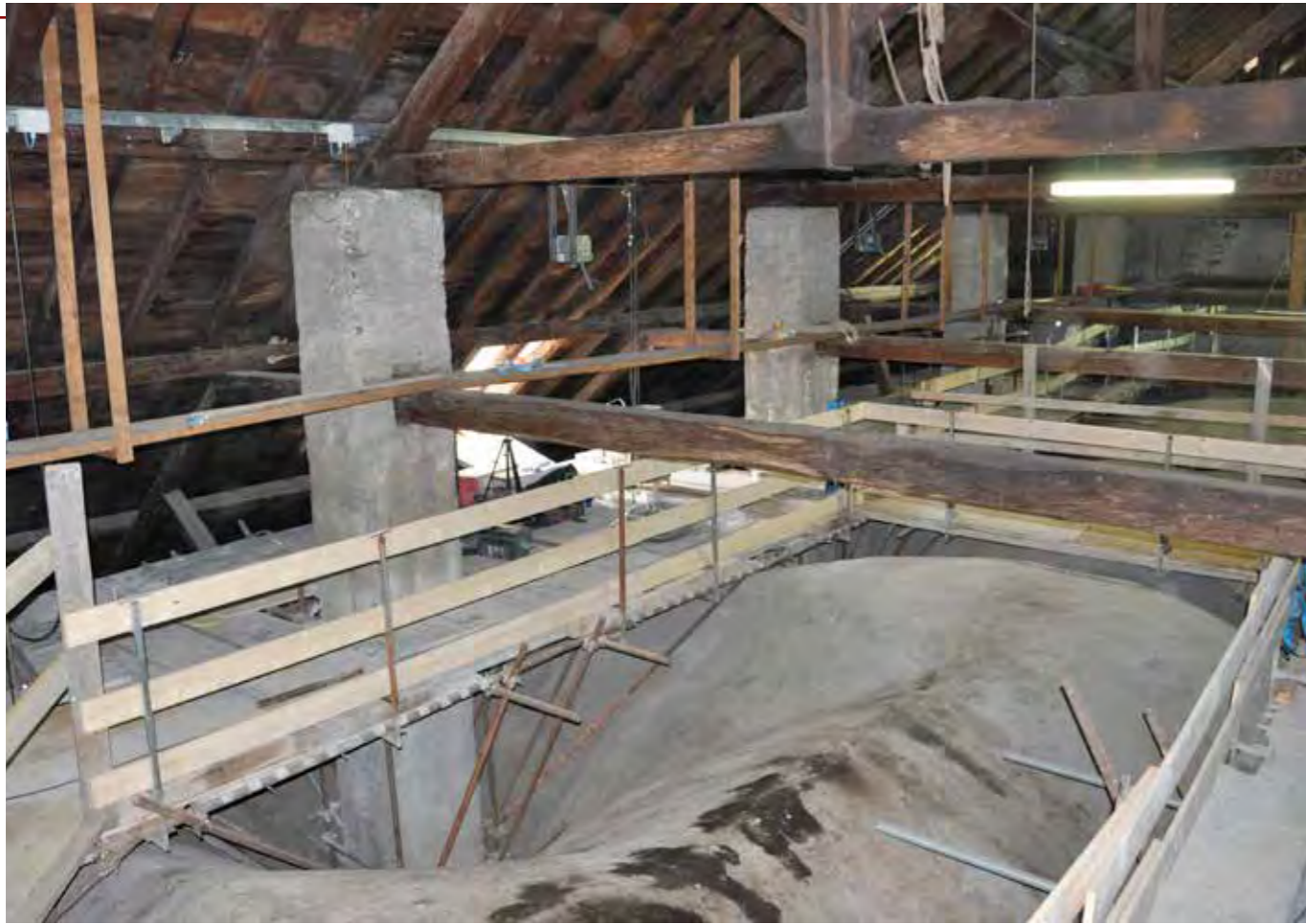
589 Layout del cantiere nell'estradosso delle volte con i piani di lavoro a fungo. Foto di M. Tomaselli
