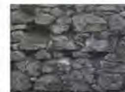
Disgregazione del giunto a causa della presenza di elementi incoerenti quali lenticcio
