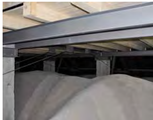
589 Layout del cantiere nell'estradosso delle volte con i piani di lavoro a fungo. Foto di M. Tomaselli
