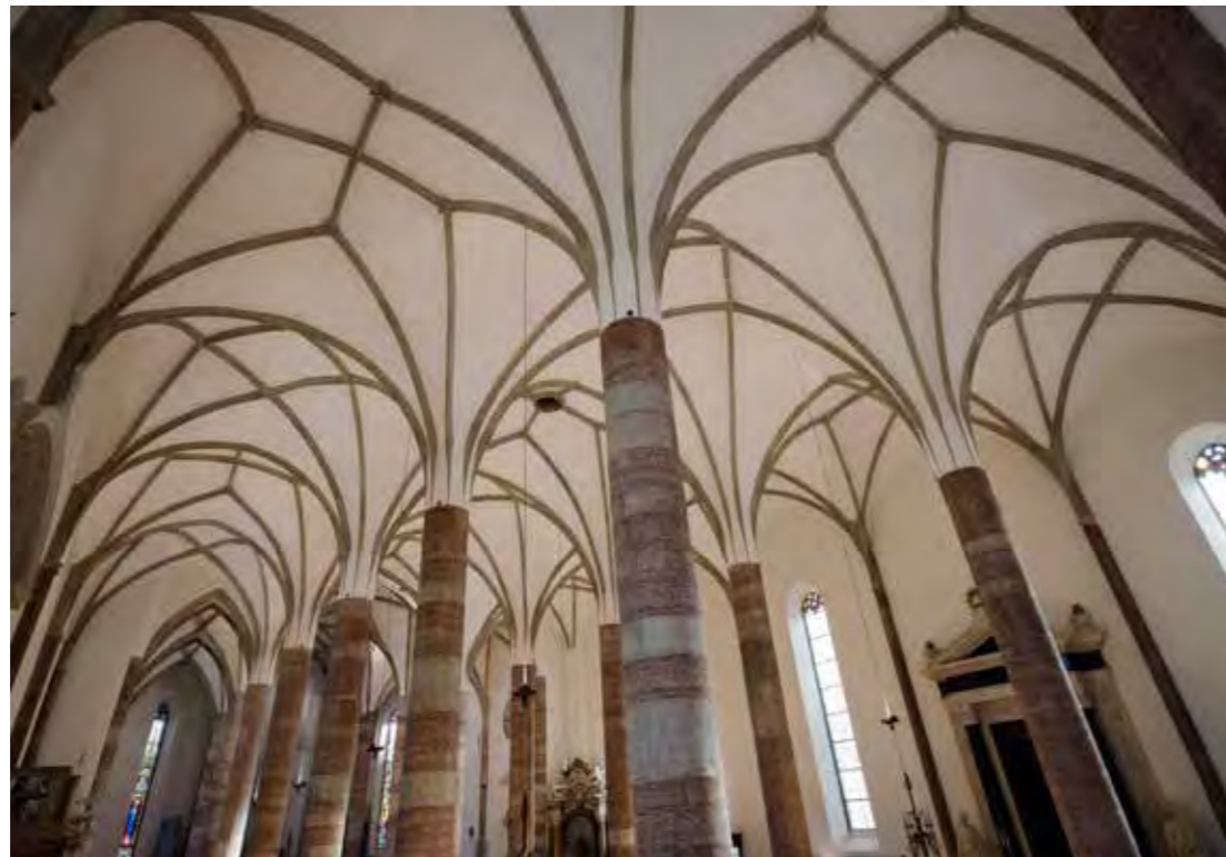
571 Le nervature della volta che si dipartono dai pilastri delle navate. Foto Mariotti
