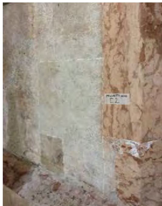
574 Campionatura eseguita per il restauro degli intonaci esterni. Foto di P. Neri (2009)
