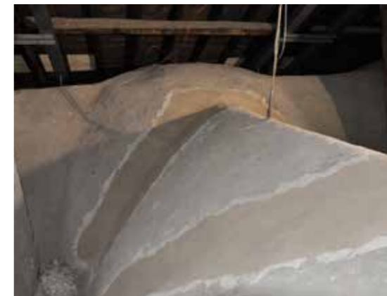
592 Operazioni di pulitura delle fessure passanti. Foto di M. Tomaselli
