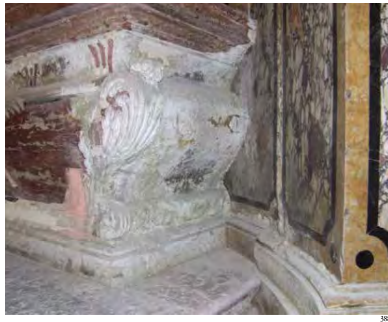
388 Antependio dell'altare laterale della Natività: degrado da umidità di risalita. Foto Consorzio ARS
