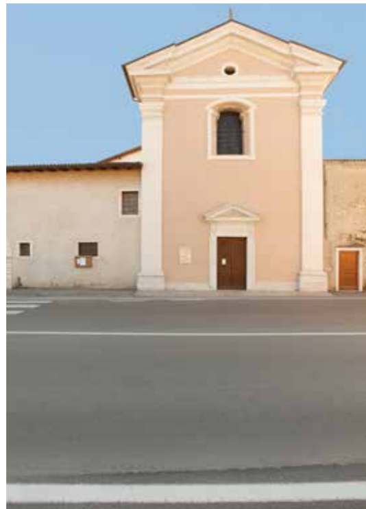
160 La facciata principale della chiesa, inserita nella cortina muraria occidentale del complesso
