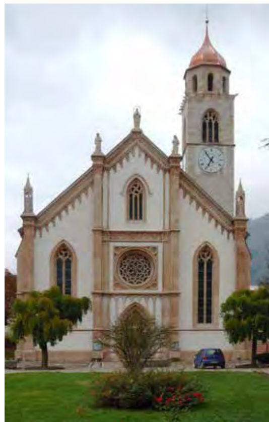
569 La facciata principale della chiesa dopo il restauro. Foto di B. Filippi (2011)
